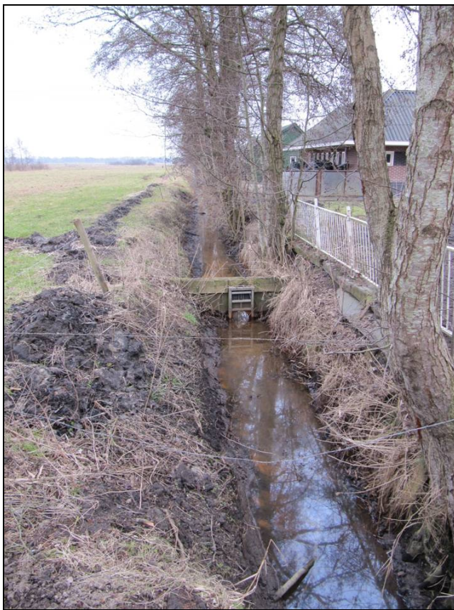
Huidige waterverbinding Doezumermieden-Polder de Kaleweg
